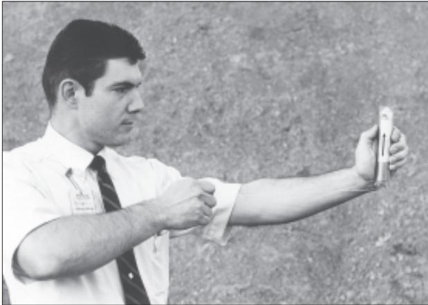
Fig. 28-78. MBA 25mm Gyrojet flare launch. MBA photo.
